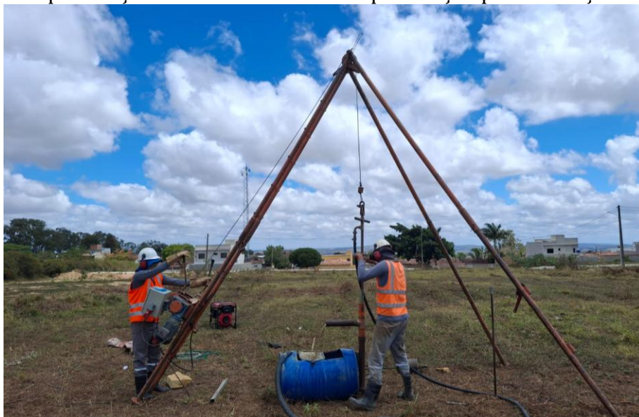
Foto 08 – Execução de sondagem de simples reconhecimento com SPT do furo SP-04, com avanço da perfuração através do método de perfuração por circulação de água.
