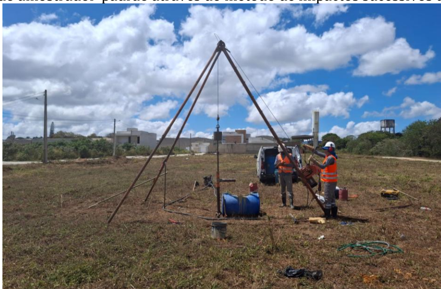
Foto 07 – Execução de sondagem de simples reconhecimento com SPT do furo SP-04, com a cravação do amostrador-padrão através do método de impactos sucessivos do martelo.
