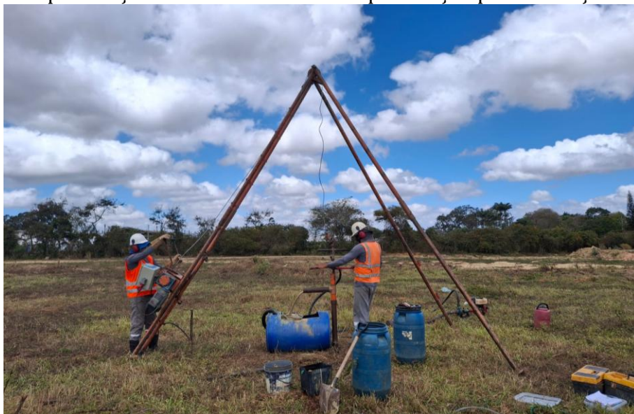
Foto 10 – Execução de sondagem de simples reconhecimento com SPT do furo SP-05, com avanço da perfuração através do método de perfuração por circulação de água.
