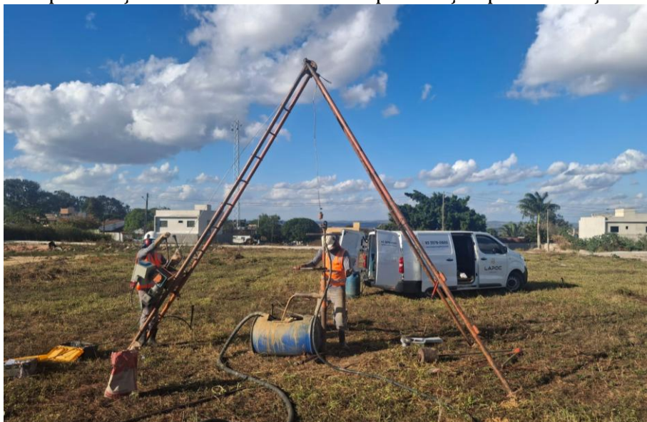
Foto 04 – Execução de sondagem de simples reconhecimento com SPT do furo SP-02, com avanço da perfuração através do método de perfuração por circulação de água.
